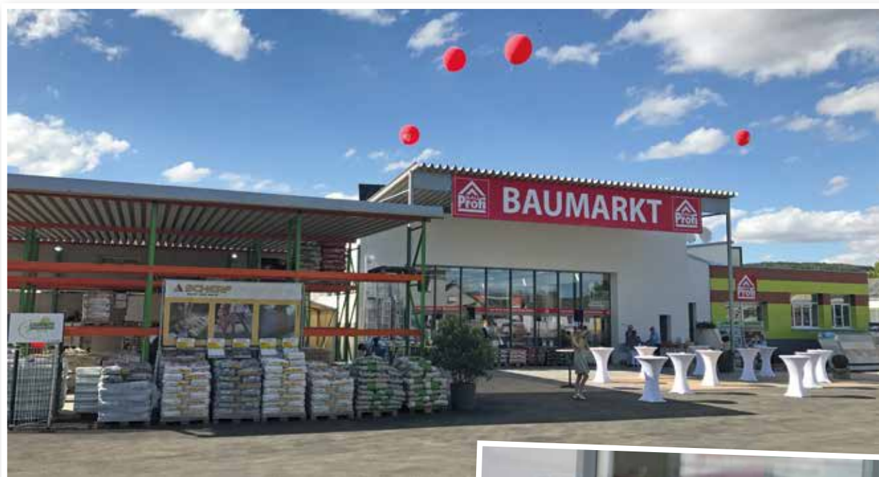
Der neue Außenaustritt BauProfii Aichinger
